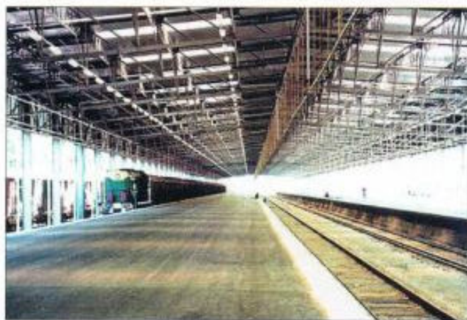
Największym atutem terminalu w Kowalewie jest 700-metrowej długości kryta wiatą nad rampą umożliwiającą przeładunek towarów w relacji wagon szeroki – wagon wąski
